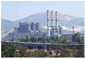
YATAĞAN TERMİK SANTRALİ 2. VE 3. ÜNİTELER, GAZ KANALLARI VE MUHTELİF YAPISAL ÇELİK İMALAT VE MONTAJ İŞLERİ YATAĞAN/MUĞLA
