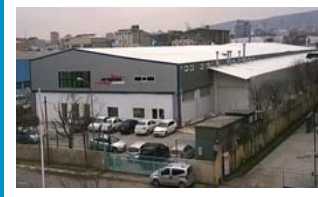
ARMSAN SİLAH FABRİKASI FABRİKA BİNASI ANAHTAR TESLİMİ İNŞAATI ÜMRANİYE/İSTANBUL
