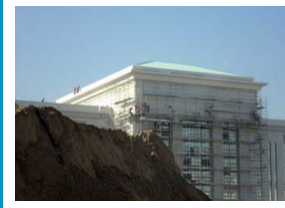
TÜRKMEN ÜNİVERSİTESİ ÇATI KATI YAPISAL ÇELİK, TRAPEZ SAÇ KAPLAMA, YANGIN VE ÇELİK KAPILARI İŞLERİ AŞKABAT/TÜRKMENİSTAN
