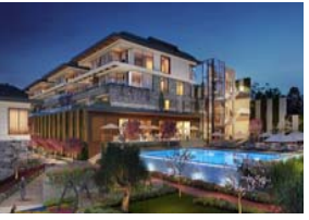
YKSEKDAĐ ÇAMLICA VİLLALARI ÇELİK KONSTRKSİYON İMALAT VE MONTAJLARI SKDAR/İSTANBUL
